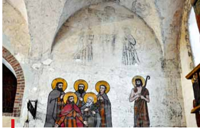
Na ścianie północnej prezbiterium pod kolorowymi malowidłami z połowy XIX w. podczas prac odkryto polichromie renesansowe
